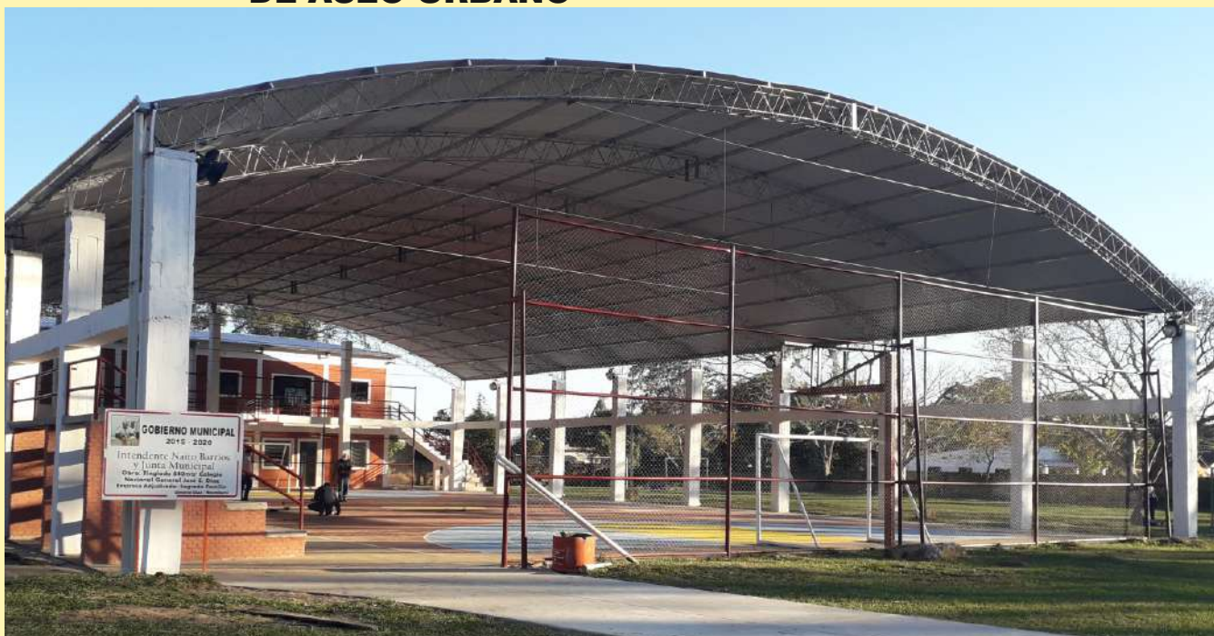
CONSTRUCCIÓN DE TINGLADO MULTIUSO EN EL COLEGIO NACIONAL DE GRAL DÍAZ.
