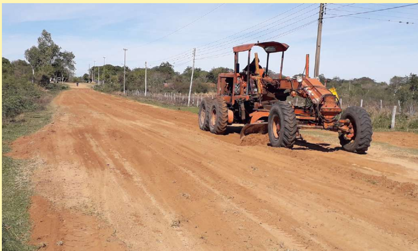
OBRAS VIALES CON TRABAJOS DE PERFILADOS CON MOTONIVELADORA EN DIFERENTES ZONAS DEL DISTRITO.
