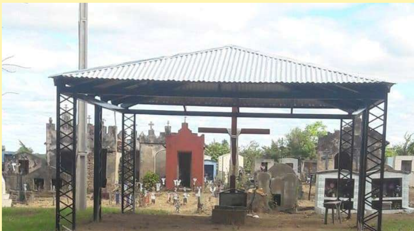
REPARACIÓN DE ALAMBRADOS, RENOVACIÓN DEL PORTÓN DE ACCESO Y CONSTRUCCIÓN DE UN TINGLADO EN LA ENTRADA DEL CAMPOSANTO DE LOMA GUAZÚ.
